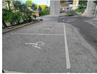
Parkplatz unter der Brücke
