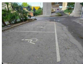
Parkplatz unter der Brücke
