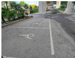
Parkplatz unter der Brücke
