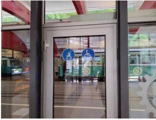
Tür von der Wartehalle zum Bahnsteig Talstation
